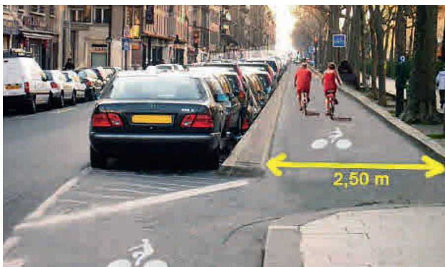
Piste cyclable séparée du trafic : sécurité.
