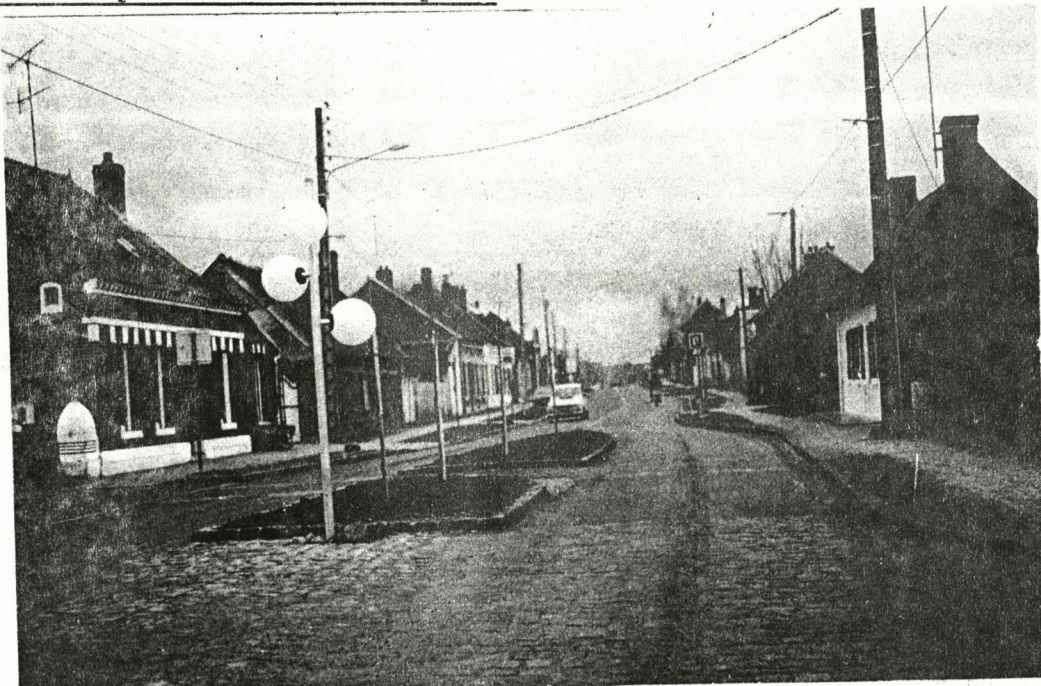
Traversée de Golancourt après réalisation.
