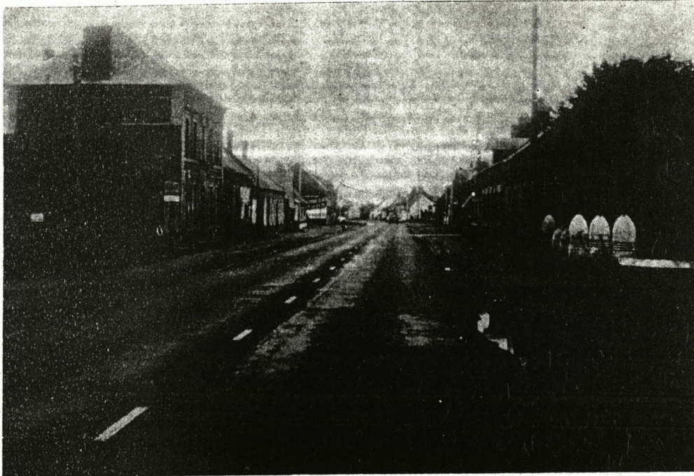
Traversée de Golencourt avant réalisation.
