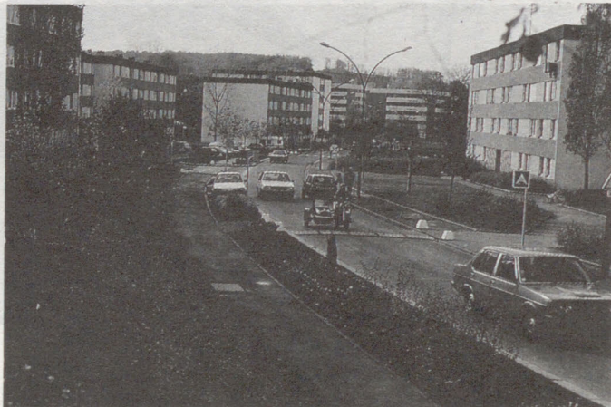
Avenue G. Pompidou (Vire) après les aménagements
